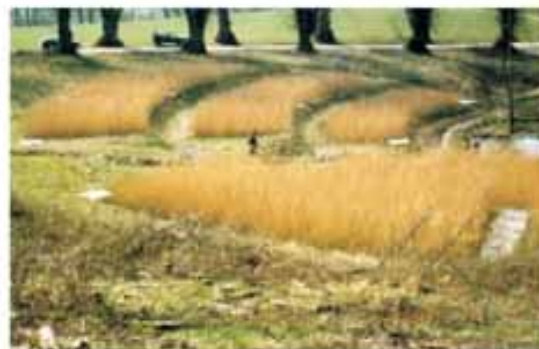
2. Kép Nádgyökérzónás szennyvíztisztító telep Németországban (forrás www.foek.hu )
